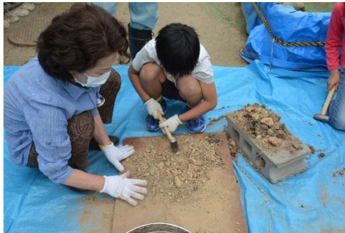
▲解体した土は再利用にむけて細かく。
