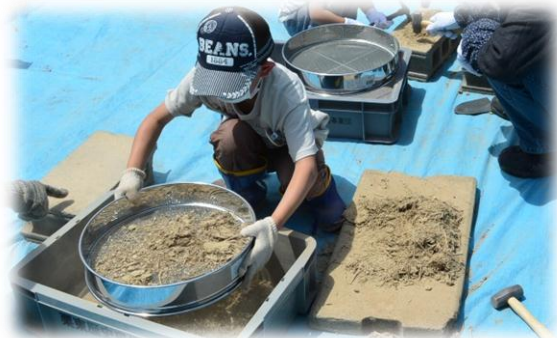
作業② 前回解体した土をフルイにかけるなどして、細かくする。
